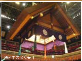
場所中の吊り天井
