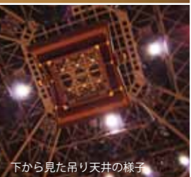
下から見た吊り天井の様子
